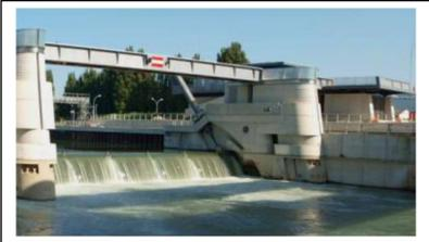
Pour permettre le transport fluvial tout en tenant compte des risques de crues, des **barrages de navigation** (à clapet) ont été installés. Ils contribuent également à fiabiliser l'alimentation en eau potable des populations ainsi que les besoins des industries et de l'agriculture.
