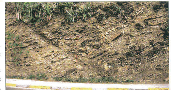
Pied de la cathédrale de Nouméa, boulevard Vauban. Ces roches sédimentaires, déposées il y a 40 millions d'années, sont des grès plus ou moins grossiers associés à des marnes (matériaux contenant de l'argile). Leur stratification est perturbée par des failles. L'une d'elles apparaît clairement en bas et à gauche de la vue.
