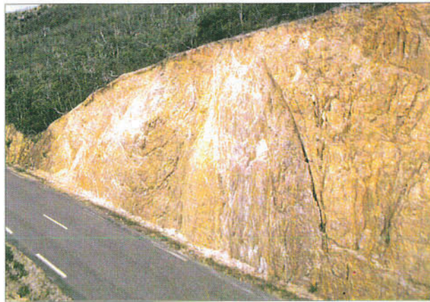
RPN7, entre Koumac et le col de Crève-cœur, nord de la Grande Terre. Le talus est creusé dans des roches sédimentaires siliceuses, stratifiées. Ce sont des phthanites semblables à celles rencontrées à Nouméa (Ouen-Toro, Nouville, Mont Vénus). Ici elles sont plissées, faillées. Au centre du cliché apparaît un pli en cuvette et, à droite, une faille est visible.
