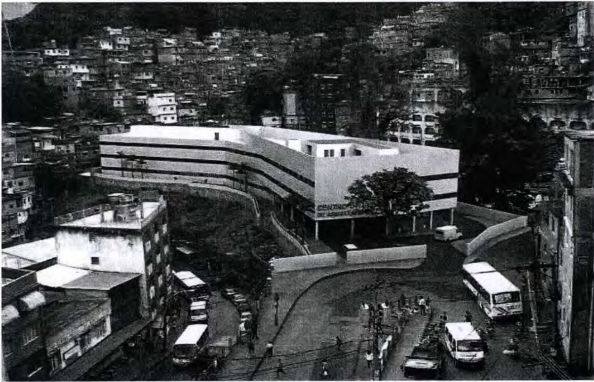
La construction future de l'hôpital fait partie du vaste chantier (Projet pour l'accélération de la croissance PAC) lancé par le président Lula en 2007 dans 3 favelas brésiliennes. Source: journal brésilien Globo.com (août 2009).
