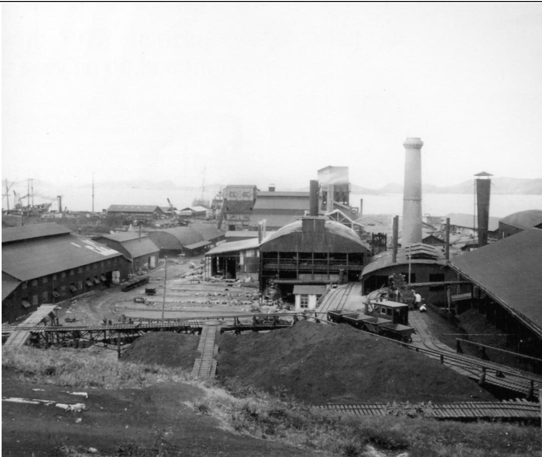
Construite en 1910 par la Société des Hauts Fourneaux de Nouméa (Ballande) elle était équipée de fours Bessemer capables de produire des mattes à 76% de nickel. Dans les années 20 sa production a dépassé celle de la SLN à Thio-Mission mais en 1937 c'est finalement la SLN qui en prend le contrôle et s'y installe.
