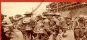
Préparation des tranchées pour la bataille de Croisne le 10/11/1917. Source : les archives militaires de la 2 e division de France, les 1917.
