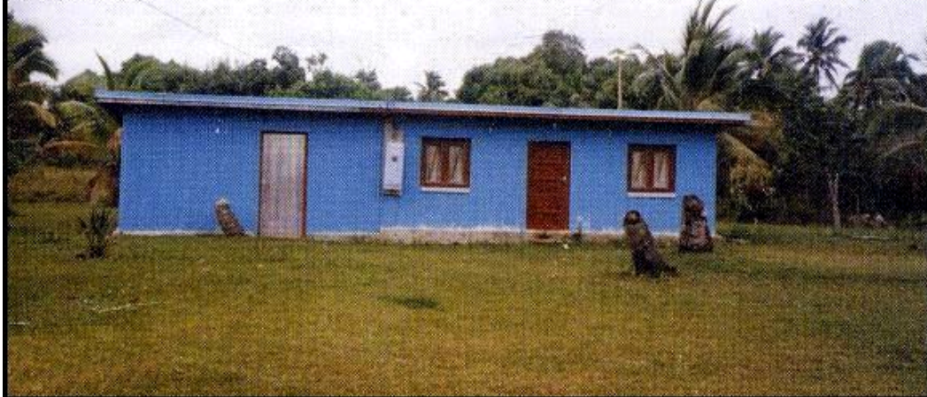
Une maison en tôle. Si certaines de ces habitations sont très sommaires, d'autres sont habillées de lambris à l'intérieur et peuvent offrir un confort satisfaisant.
