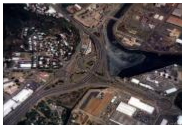
Entrée de la Zone Industrielle et Artisanale de Ducos
