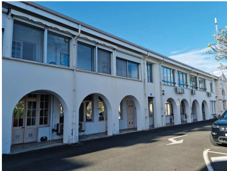
Caserne Meunier : le bâtiment nord - © Jean-Luc FAURE - Novembre 2022
