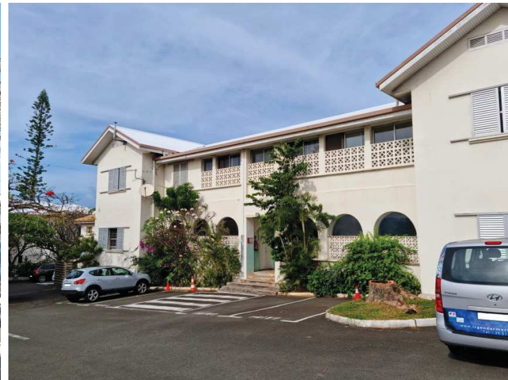
Caserne Meunier : le bâtiment ouest - © Jean-Luc FAURE - Novembre 2022
