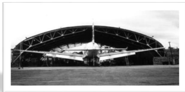
Hangar du DC6, aéroport de La Tontouta, 1967.
