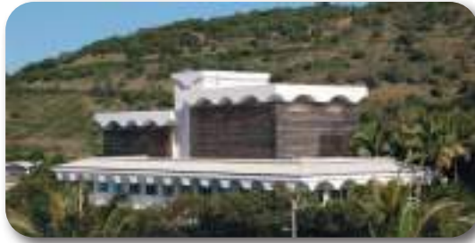
Le bâtiment des Archives de la Nouvelle-Calédonie
