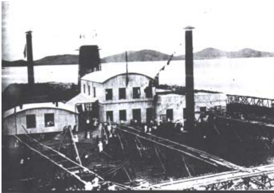
L'usine de la Société des Hauts Fourneaux en 1910 (photo SLN)
