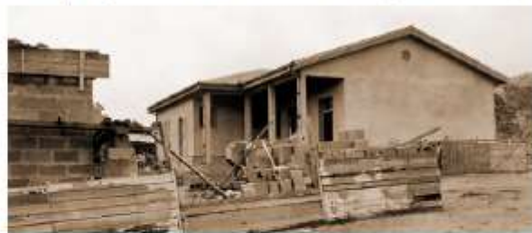
École de Gouaro en construction | Coll. ANC 2 Hum 3-297
