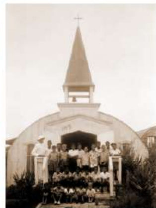
L'ancienne chapelle reconvertie en trois salles de classe
