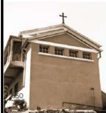
La fin du chantier de la construction de l'école du Sacré-Cœur en 1946 | Coll. ANC 1 Num 35-4300 Cet édifice comprenait deux classes, un réfectoire et une infirmerie, et son coût s'élevait à 2 millions de francs pour laquelle le Conseil général avait accordé, en 1946, une subvention de 200 000 francs.
